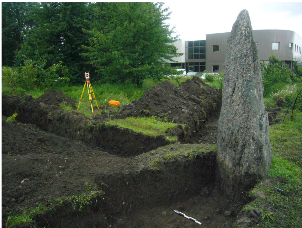
Fig.4 : Vue du chantier, lors de l'ouverture des sondages.
